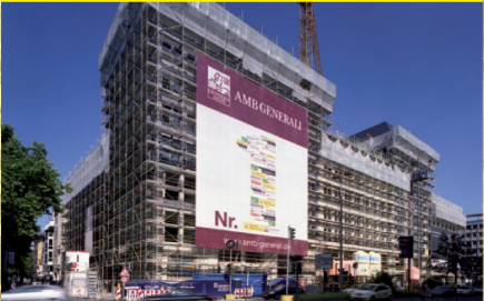
Fassadengerüst, Köln, Komödienstr., „Dominium“
